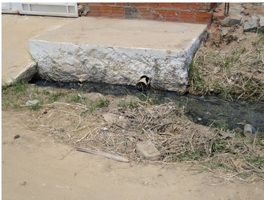
Figura 7: Vazamento de esgoto – lançamento de efluentes domésticos diretamente na rua, Bairro Novo Encontro do município de Juazeiro-BA.
